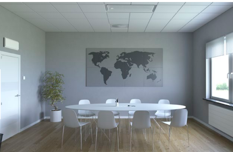
Konferencerum med ønskeværdiometer og behovsstyret luftregulering samt vandbaseret køling og styring af radiator.
