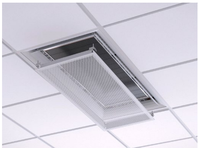
Abb. 11. Demontage des Unterblechs zum Freilegen des Registers
