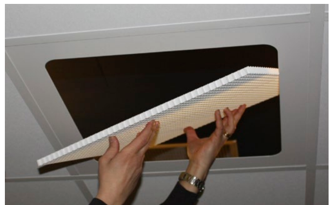
Abb. 2. Montage des RASTER in ADAPTER.
