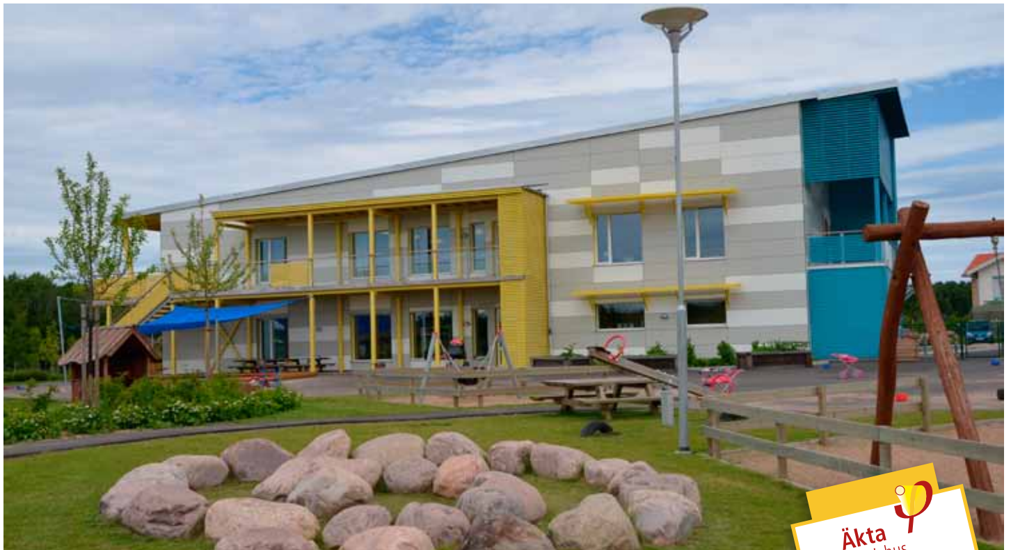
Förskolan Trädgårdsstaden i Skövde är ett certifierat Passivhus med två GOLD RX-aggregat. Foto: IG Passivhus
