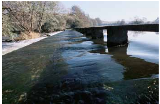
Figur 1. Brofäste med uppdammt vatten i inloppet och virvlar efter.
