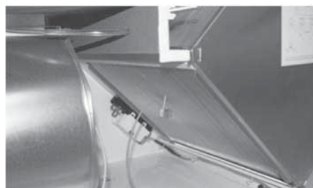
Tunnistimen paikka on merkitty kennoon (n. 5 cm kennon sivukulmasta ja n. 10 cm etureunasta)
